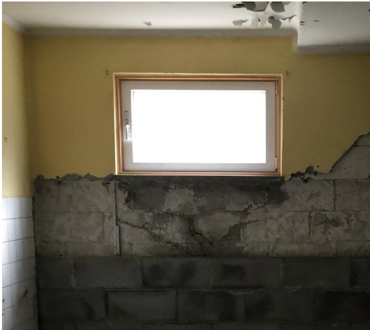
Figur 5-3 Typisk eksempel på støpekvaliteten- Bygg 7
